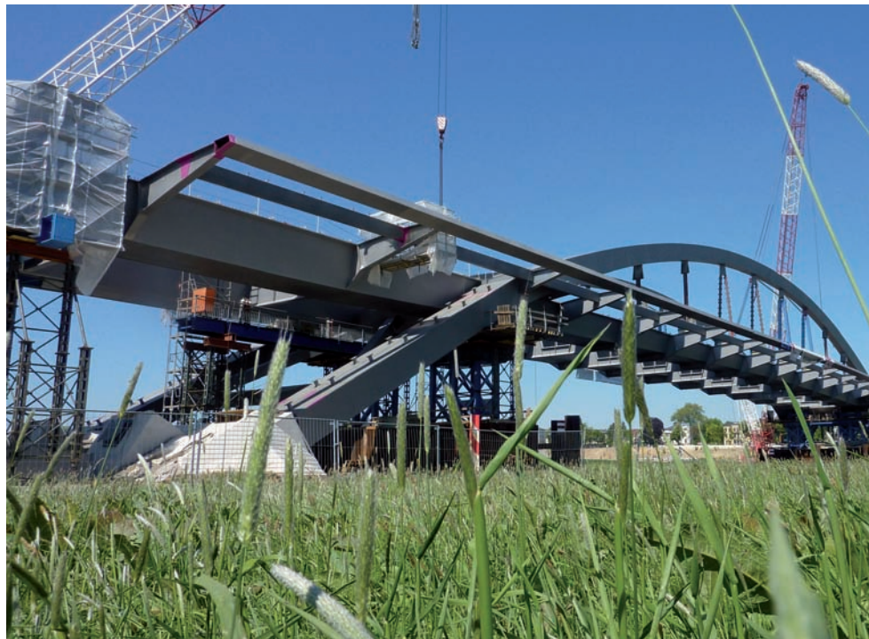
Waldschlösschenbrücke, Dresden: Umfassende rechtliche Betreuung des Stahlbaus durch die Baurechtsabteilung unserer Kanzlei
